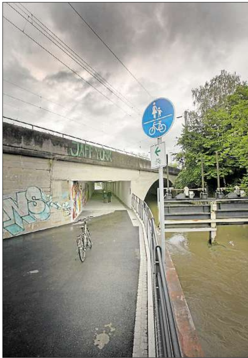
Vom Neckarufer aus kann man durch die neue Unterführung nun direkt in die Weststadt gelangen. Fotos: Bulgrin
